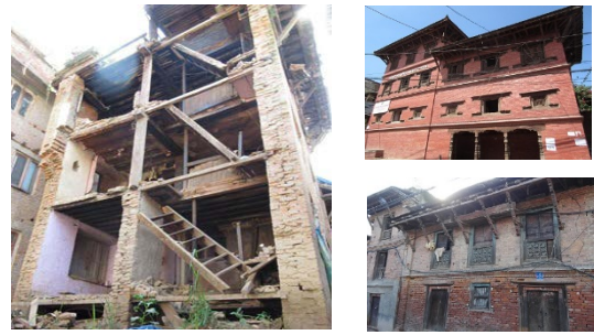
調査を行った歴史的煉瓦造建築
